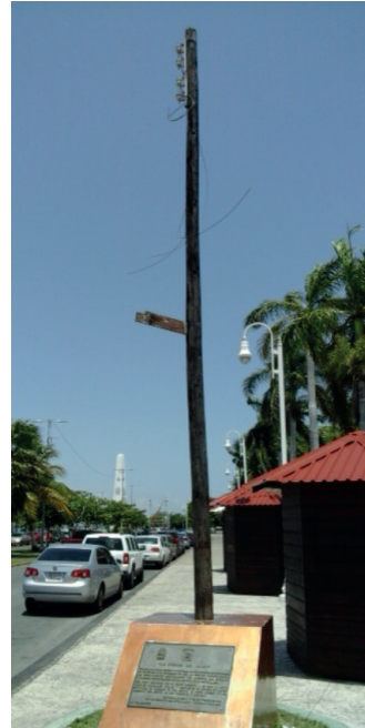
FIGURA 8. Madera que atraviesa un poste de alumbrado público. Recuerdo de la intensidad del huracán Janet en 1955
