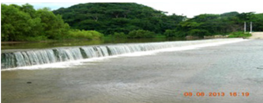
Figura 4. Cortina de la Presa
