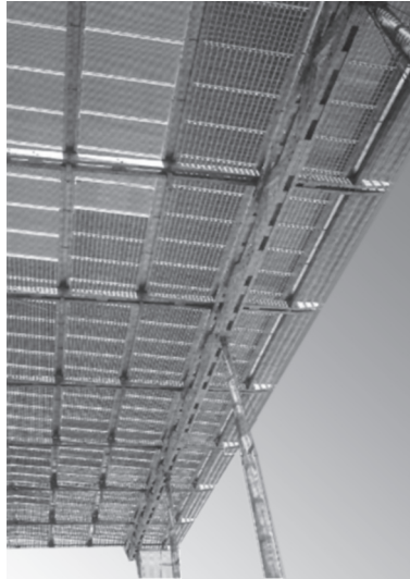
FIGURA 1. PARTE DE UNA TECHUMBRE FOTOVOLTAICA DE 10 MIL METROS CUADRADOS EN HERNE, ALEMANIA
